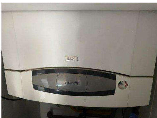
plynový kotel (foto z roku 2021)
