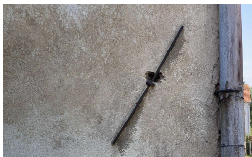
Dům byl v minulosti příčně svázán kvůli praskání
