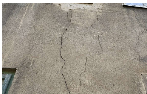
Praskliny obvodového zdiva
