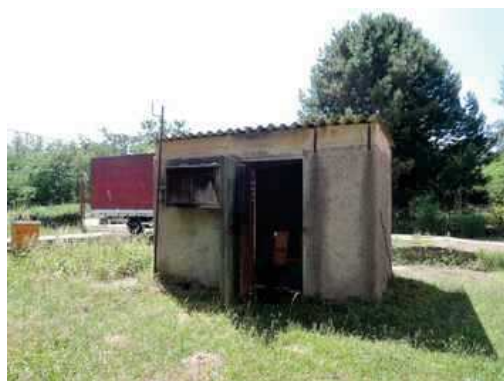
zděná vedl stavba u jímky
