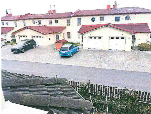
Výhled z oken v podkroví do ulice Na Skalce
