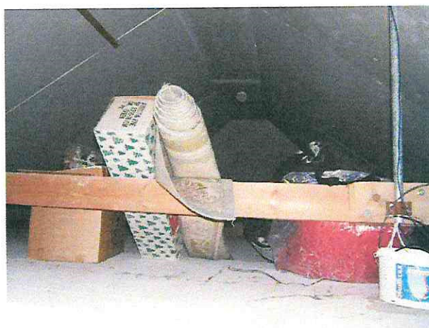
Zateplený skladový prostor v 2. podkroví
