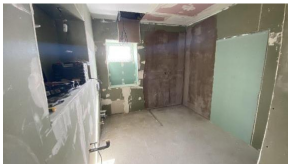
Nedokončený byt v patře
