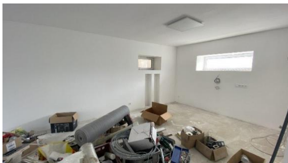
Nedokončený byt v patře
