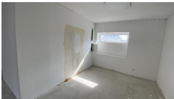
Nedokončený byt v patře
