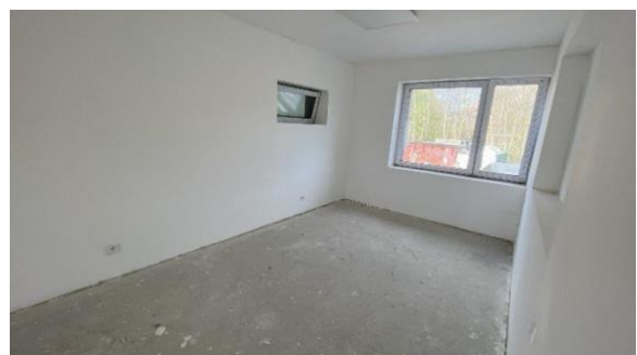
Nedokončený byt v patře
