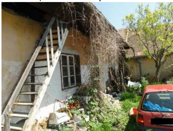
Dvorní pohled na RD
