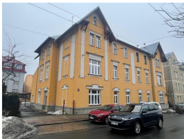
čelní pohled z ulice a vjezd do vnitrobloku
