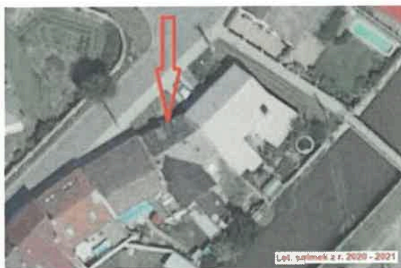
Původní střecha - let. snímek z r. 2020 - 2021
