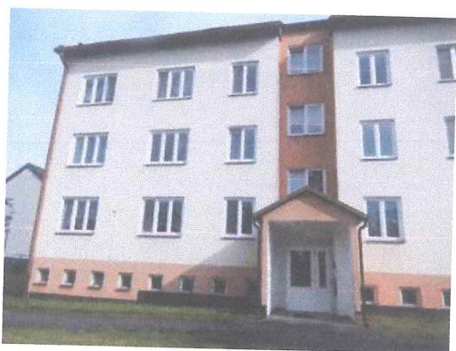
Bytový dům čp. 560,561-pohled severní
