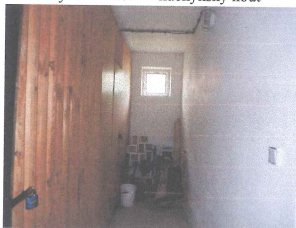
Bytový dům čp. 561 - 1 PP sklepní prostory
