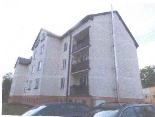
Bytový dům čp. 560,561-pohled východní
