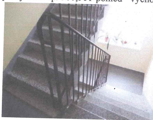
Bytový dům čp. 561- schodiště
